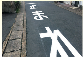
六地藏駅前 横断歩道補修
