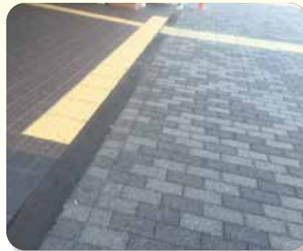
石田駅前 段差解消
