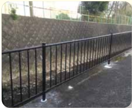
小栗栖 ポンプ場前安全対策
