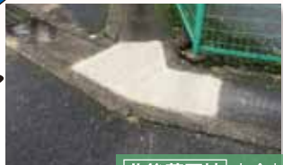
北後藤団地 安全対策
