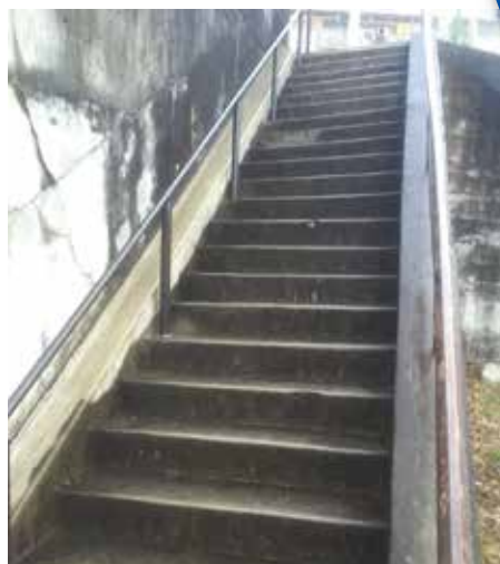
小栗栖西団地南側の階段安全対策
