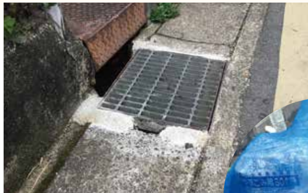
小栗栖中山田町雨水マス修復
