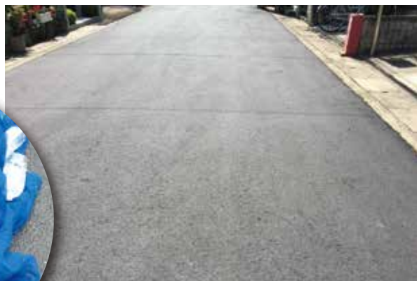
小栗栖森本町道路修復
