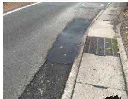
桃山東小学校前道路補修
