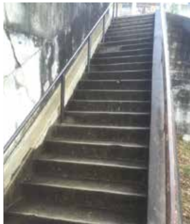
日向団地北側階段の安全対策
