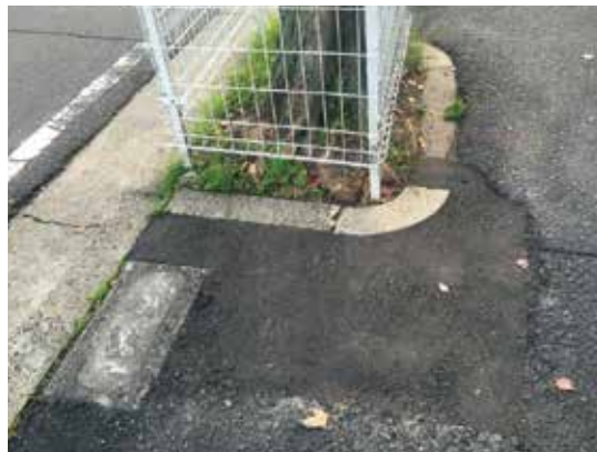
石田内里町の歩道修復
