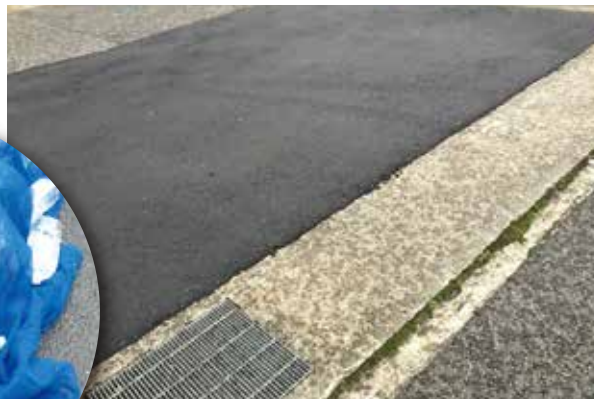
日野田中町の道路補修
