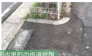
石田内里町の歩道修復
