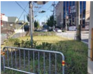
外環西尾交差点の安全対策
