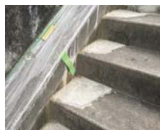
小栗栖西団地前の階段を補修
