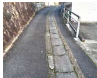
小栗栖宮山学区の坂道側溝を補修
