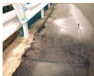
弁天橋周辺の通学路を補修
