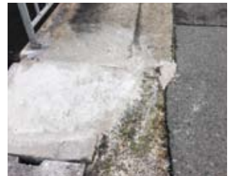
大元橋東づめの危険な段差を修理
