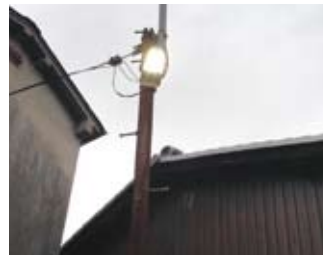
丹波橋ガード下の街灯をLED化
