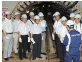
雨に強いまちづくりのため、朱雀北幹線公共下水道工事現場を視察(7/31)
