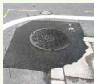
中立学区のマンホール補修
