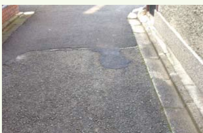
○ 仁和学区 / 道路補修
