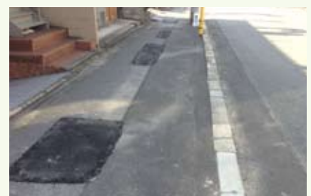
○ 室町学区 / 歩道補修
