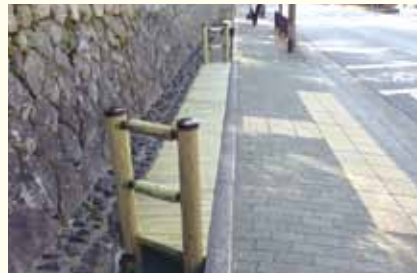
京都御苑周辺安全対策の木製デッキ
