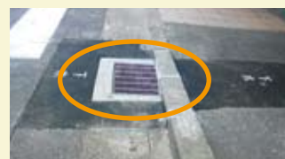
新町今出川交差点の雨水ます新設
