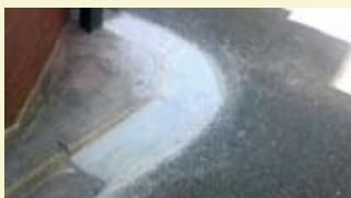
仁和寺街道浄福寺の側溝補修
