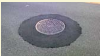
千本一条交差点のマンホール修復
