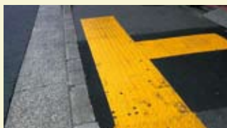
浄福寺丸太町の点字ブロック修復
