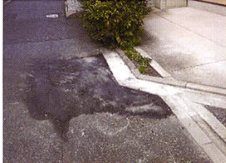
六軒町中立売下る道路補修
