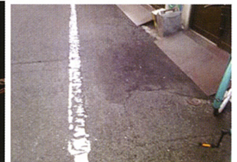
今出川油小路下る道路修復
