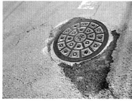
〔葭屋町出水のマンホール欠損を修復〕
