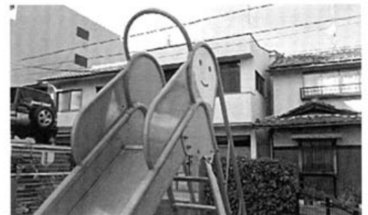
小川なかよひろばの滑り台を補修
